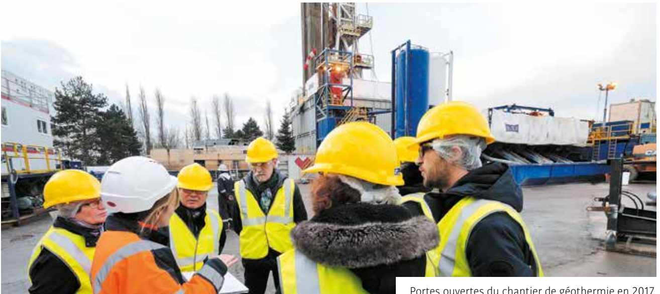
Portes ouvertes du chantier de géothermie en 2017.
