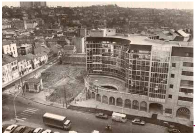
DR Le centre-ville pris en photo de l'Hôtel de Ville à la fin des années 80 avant la construction des arcades.
