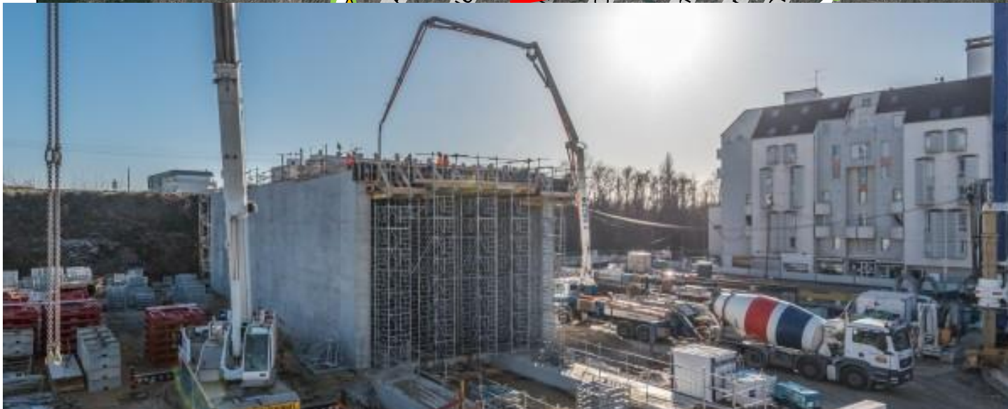
Ripage du Pont de Rail à Champigny
