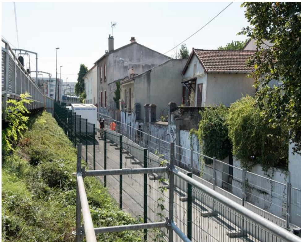
Installation de chantier
