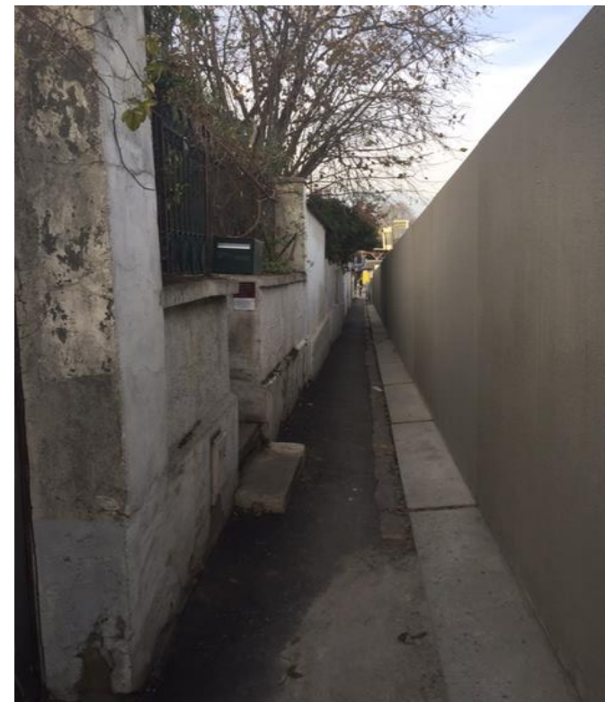
Mur en béton pour réaliser une plate forme provisoire
